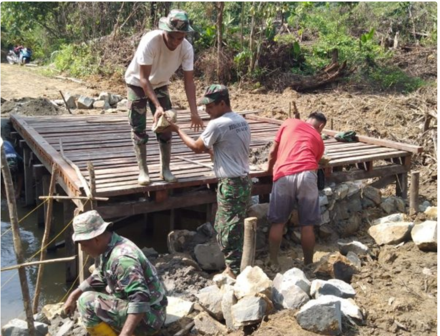
Progres Pengerjaan Jembatan TMMD Ke- 118 Wiltas Kodim 0910/Malinau Capai 65 Persen
