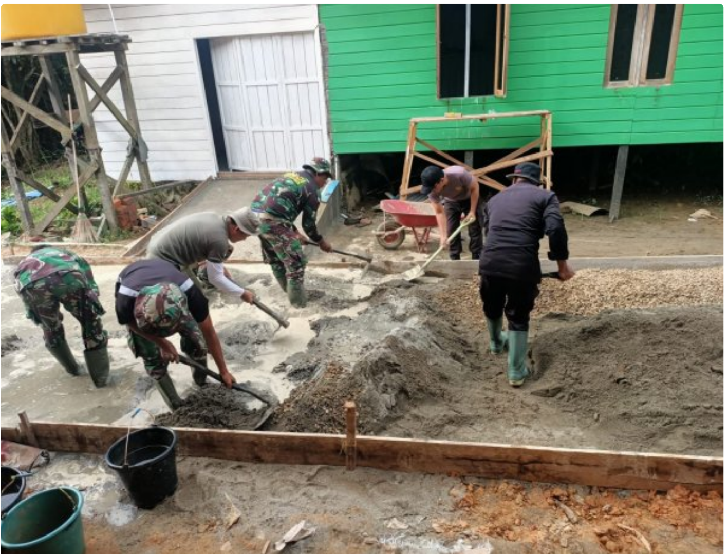
Aduk Semen Dengan Cangkul dan Skop Kebut Pembangunan Semenisasi Jalan TMMMD
